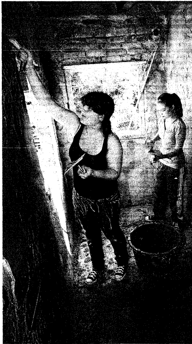
Aylin (14, l.) und Alyssa (13) beim Verputzen eines Geräteschuppens. Die beiden Mädchen aus Moabit machen diese Arbeit zum ersten Mal
